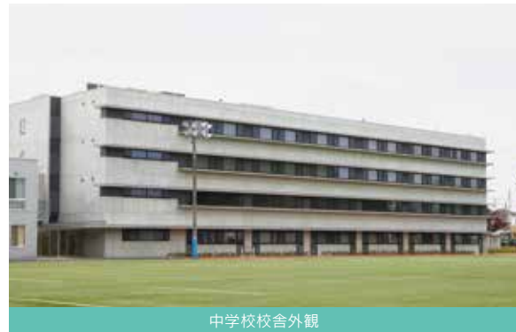
中学校校舎外観
