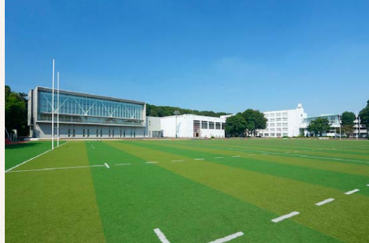
第2体育館 (2014年竣工)
